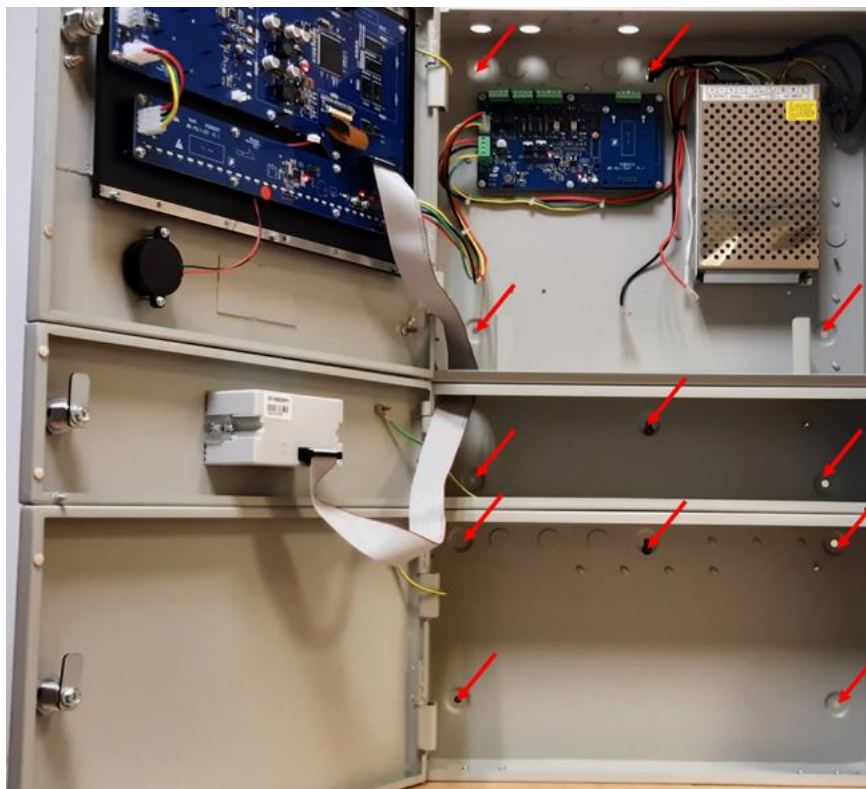
Figura 3: Ubicaciones de las perforaciones de montaje
