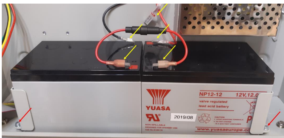
Figura 8: Ubicación de la conexión de la batería para 12 Ah
